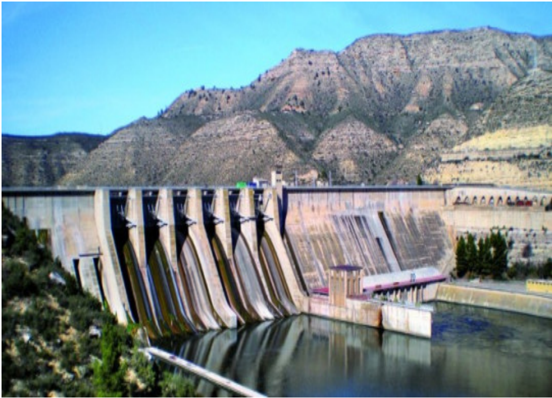
Fig. 2. Planta hidroeléctrica de Mequinenza (Spain).
